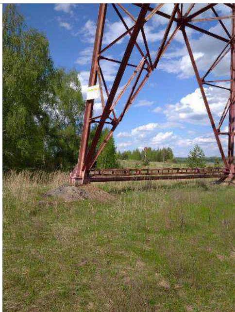
Фото 29. Прилегающая территория и подъездные пути.
