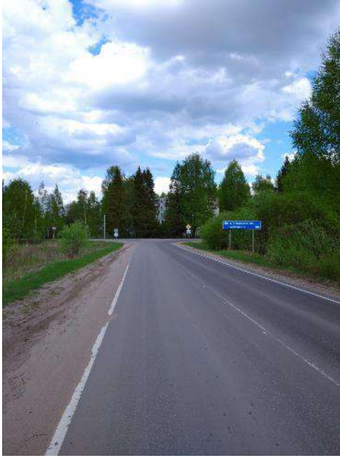
Фото 23. Прилегающая территория и подъездные пути.
