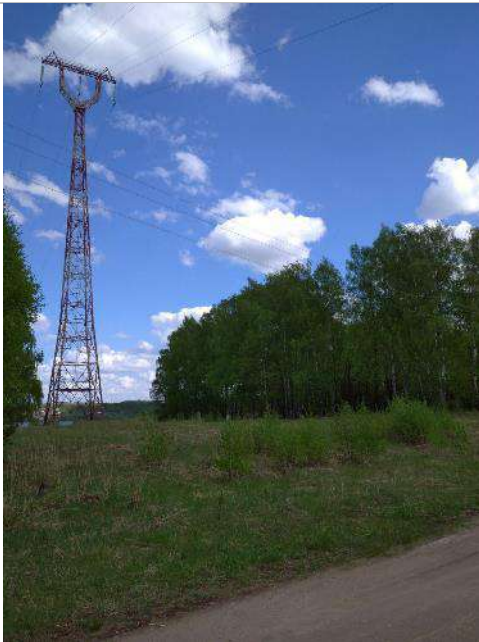
Фото 25. Прилегающая территория и подъездные пути.
