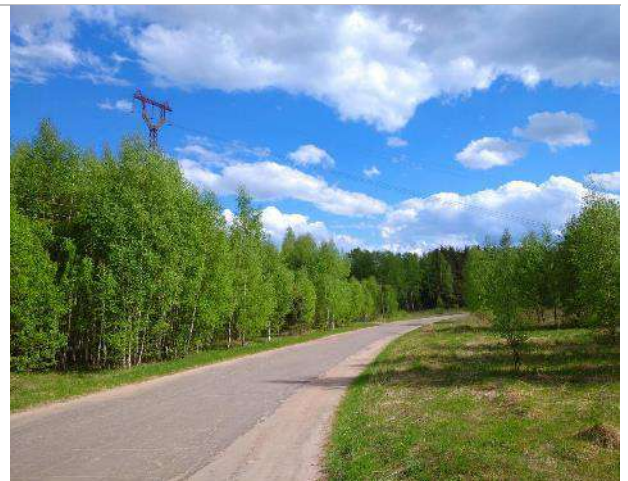
Фото 34. Прилегающая территория и подъездные пути.
