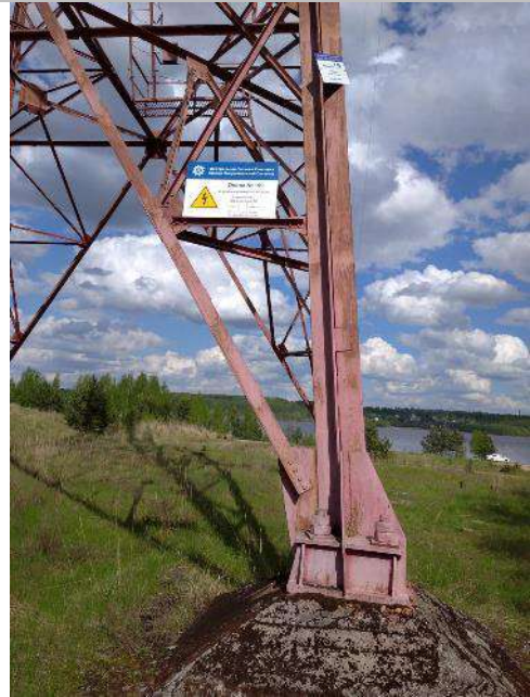
Фото 40. Прилегающая территория и подъездные пути.
