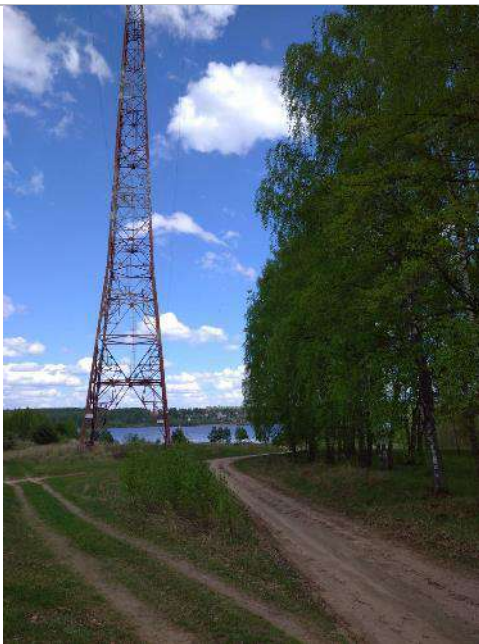
Фото 41. Прилегающая территория и подъездные пути.
