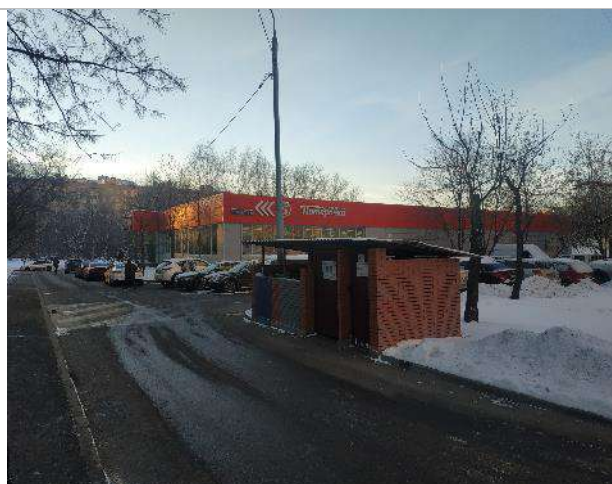
Фото 5. Фасад здания и прилегающая территория
