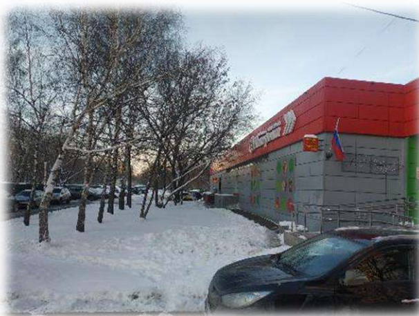
Фотография 3.4. Прилегающая территория, фасад здания
