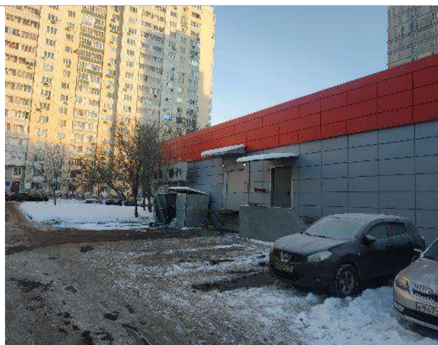
Фото 11. Фасад здания и прилегающая территория
