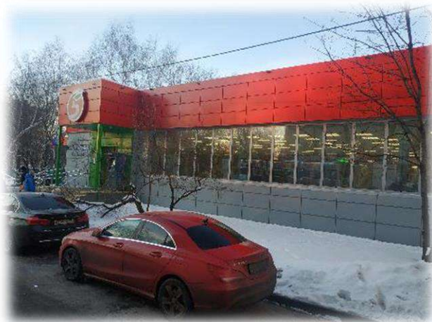
Фотография 3.3. Прилегающая территория, фасад здания
