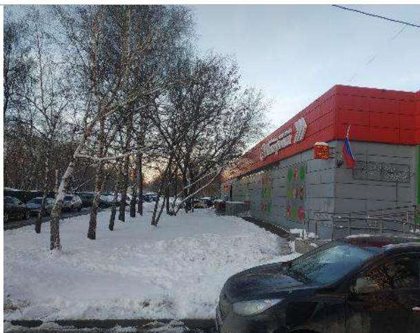
Фото 8. Фасад здания и прилегающая территория
