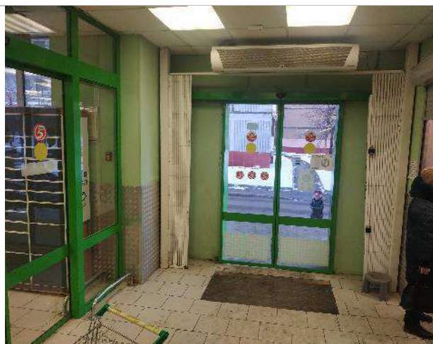
Фото 15. Фрагменты внутренних помещений
