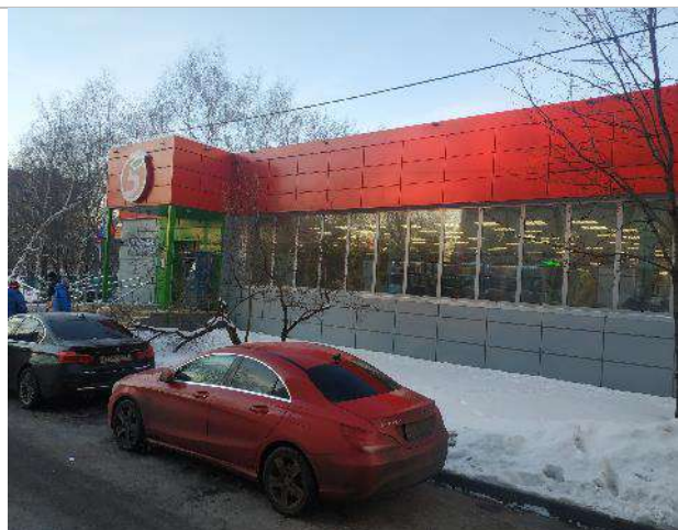
Фото 7. Фасад здания и прилегающая территория
