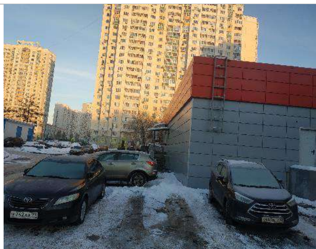
Фото 9. Фасад здания и прилегающая территория
