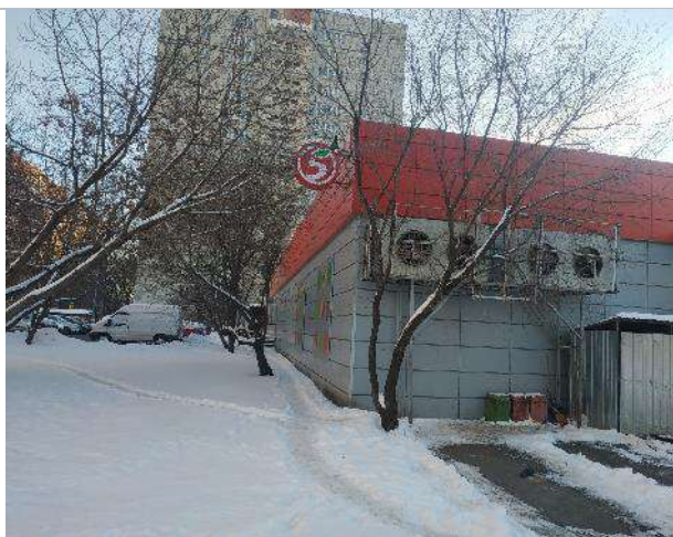
Фото 12. Фасад здания и прилегающая территория
