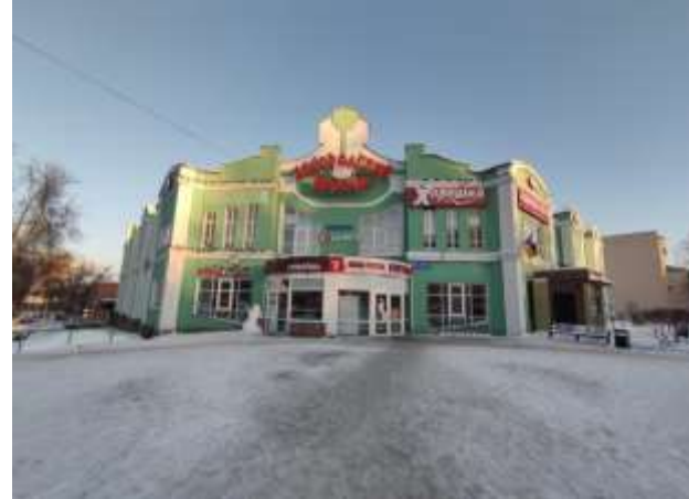
Общий вид здания
