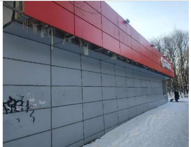
Фото 4. Внешний вид здания
