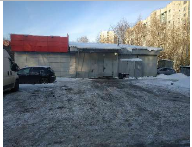
Фото 2. Внешний вид здания
