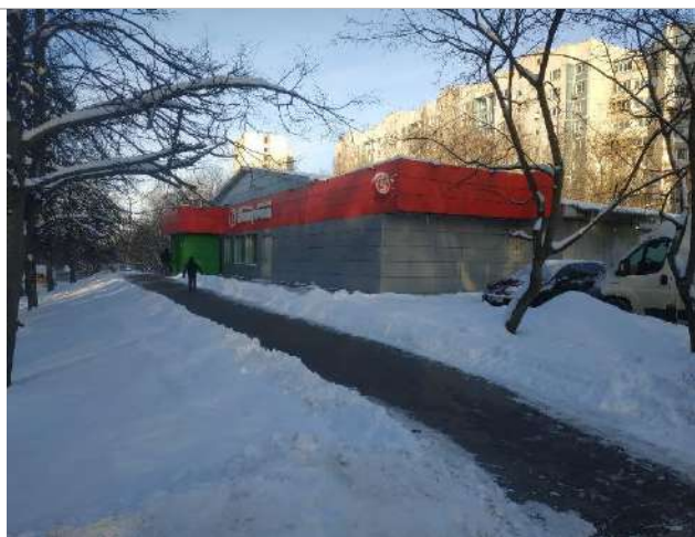
Фотография 3.3. Прилегающая территория, фасад здания
