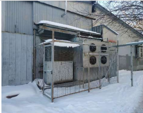
Фото 3. Внешний вид здания
