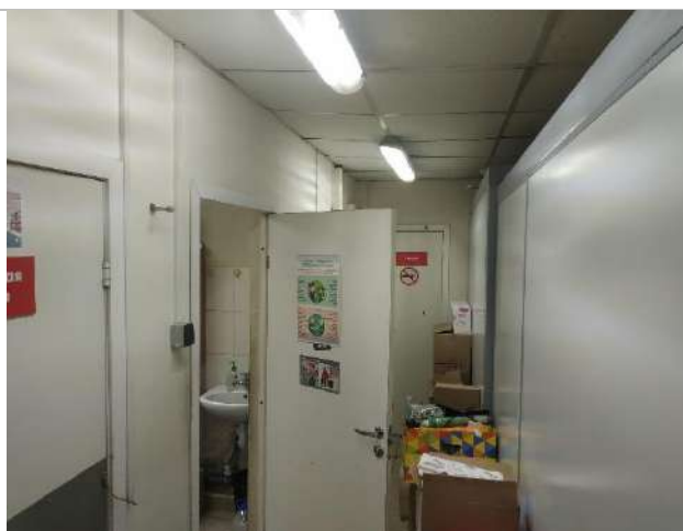
Фотография 3.12. Состояние внутренних помещений
