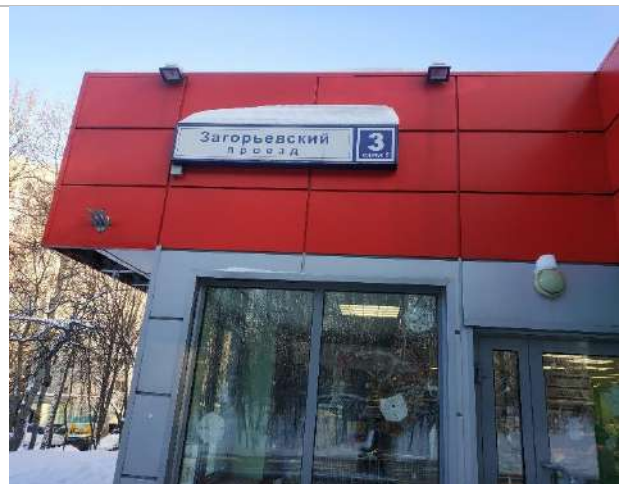
Фото 6. Внешний вид здания
