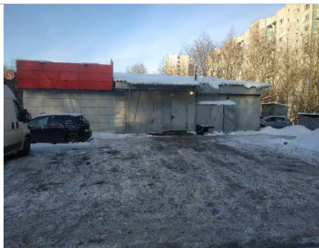
Фотография 3.4. Прилегающая территория, фасад здания
