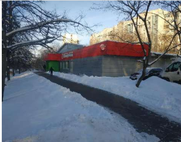
Фото 1. Внешний вид здания
