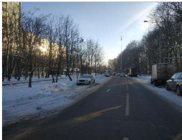
Фотография 3.2. Подъездные пути
