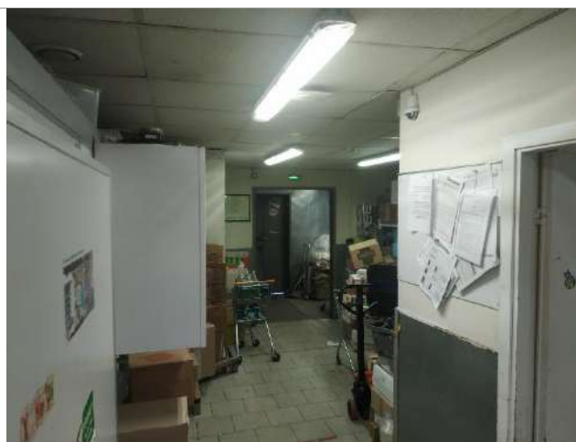
Фотография 3.11. Состояние внутренних помещений
