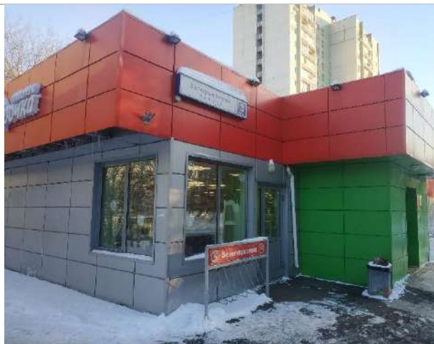
Фото 5. Внешний вид здания
