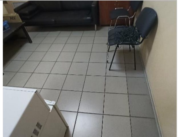
Фото 68. Фрагменты внутренних помещений 2-го этажа
