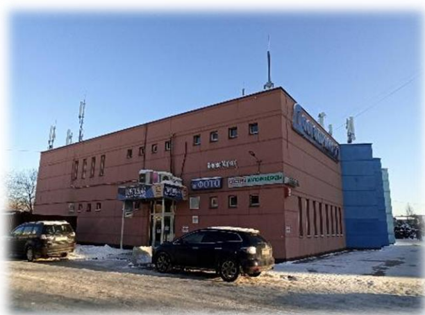
Фотография 3.3. Прилегающая территория, фасад здания
