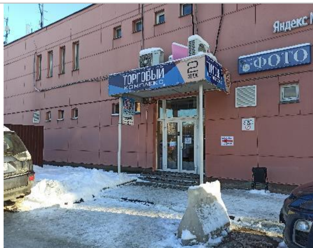
Фото 86. Фасад здания и прилегающая территория
