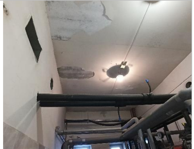
Фото 20. Фрагменты внутренних помещений 1-го этажа
