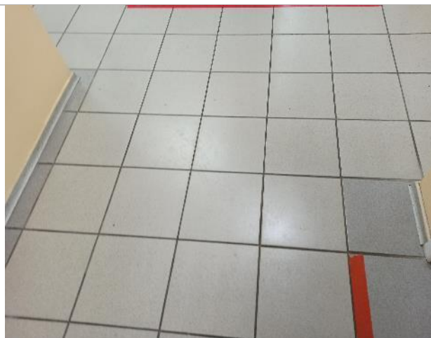
Фото 29. Фрагменты внутренних помещений 2-го этажа
