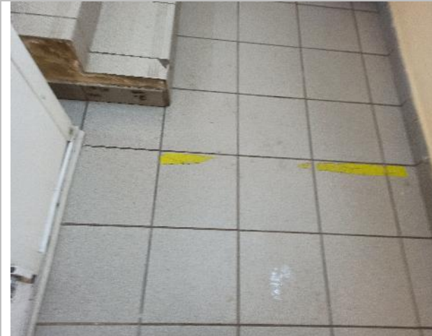
Фото 7. Фрагменты внутренних помещений 1-го этажа
