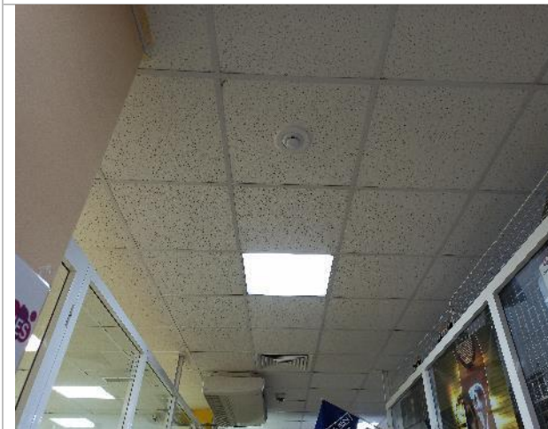
Фото 33. Фрагменты внутренних помещений 2-го этажа
