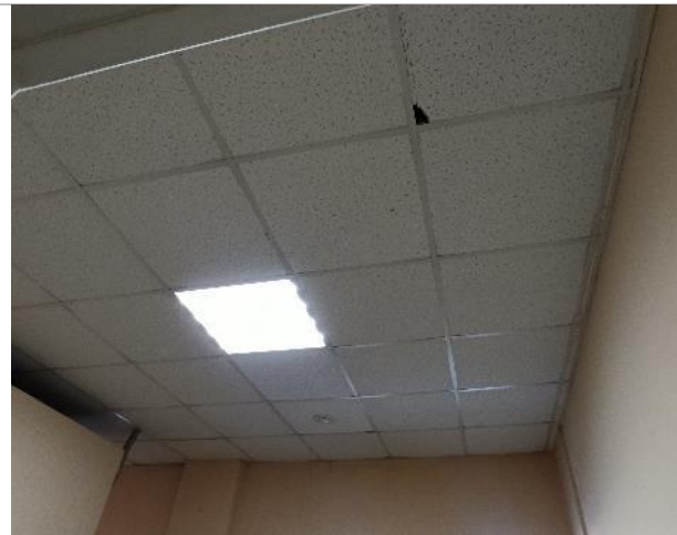
Фото 69. Фрагменты внутренних помещений 2-го этажа
