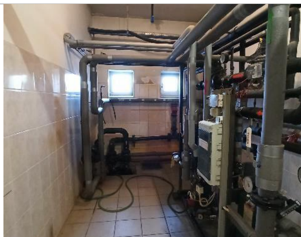
Фото 16. Фрагменты внутренних помещений 1-го этажа
