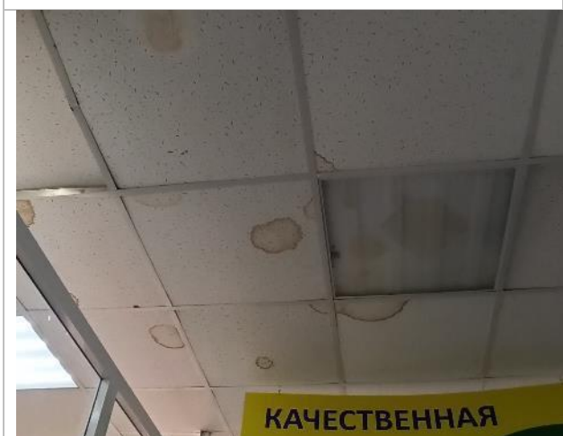
Фото 51. Фрагменты внутренних помещений 2-го этажа
