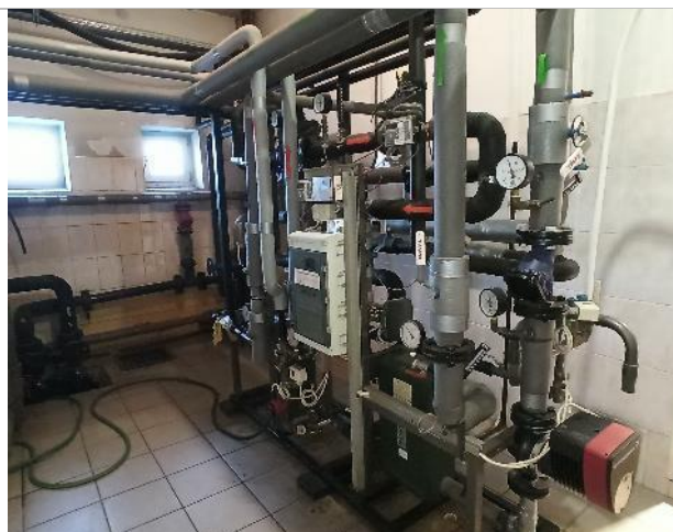
Фото 18. Фрагменты внутренних помещений 1-го этажа
