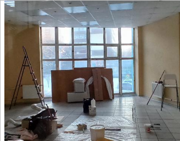
Фото 55. Фрагменты внутренних помещений 2-го этажа
