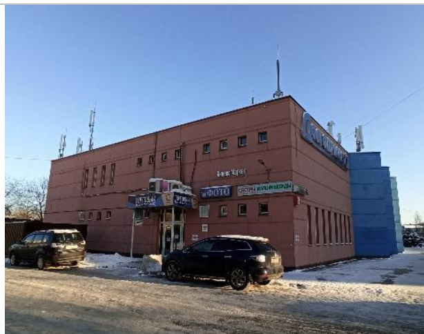
Фото 85. Фасад здания и прилегающая территория
