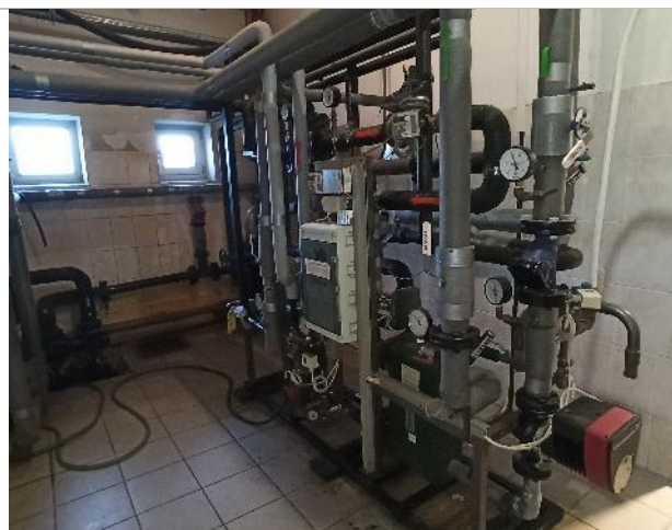
Фото 17. Фрагменты внутренних помещений 1-го этажа
