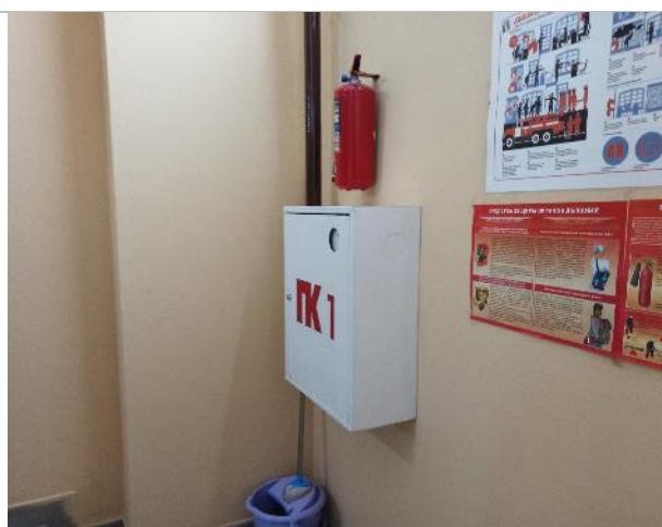
Фото 6. Фрагменты внутренних помещений 1-го этажа
