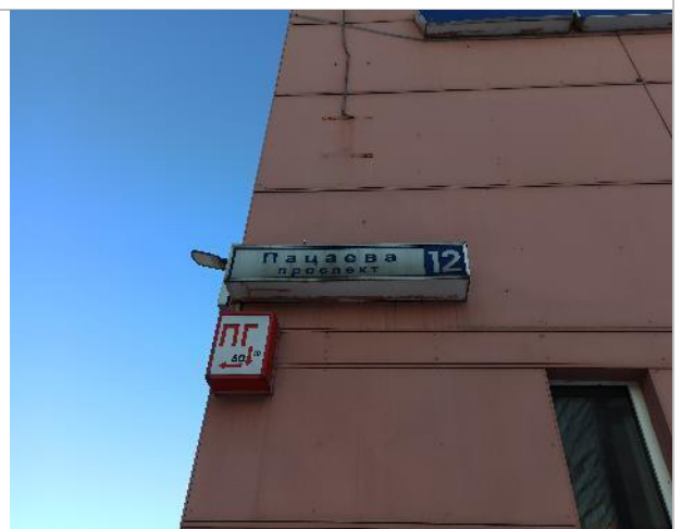
Фото 84. Фасад здания и прилегающая территория
