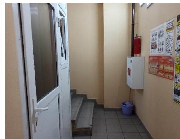
Фото 5. Фрагменты внутренних помещений 1-го этажа
