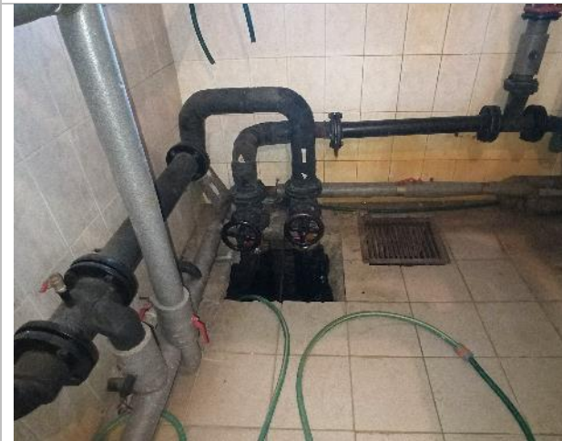
Фото 21. Фрагменты внутренних помещений 1-го этажа
