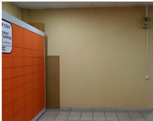
Фото 38. Фрагменты внутренних помещений 2-го этажа
