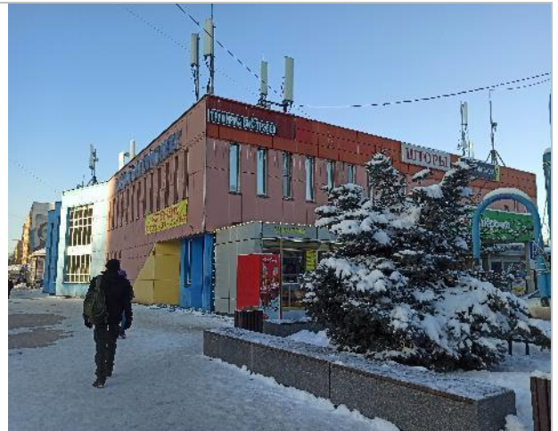
Фото 80. Фасад здания и прилегающая территория
