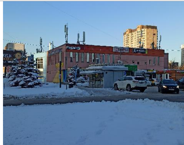
Фото 79. Фасад здания и прилегающая территория
