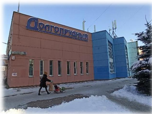
Фотография 3.4. Прилегающая территория, фасад здания
