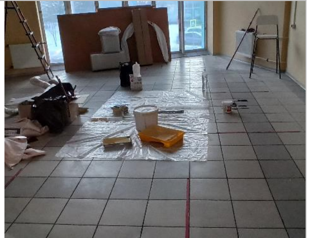
Фото 56. Фрагменты внутренних помещений 2-го этажа
