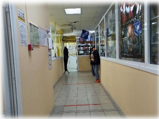
Фотография 3.9. Состояние внутренних помещений
