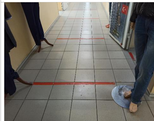
Фото 35. Фрагменты внутренних помещений 2-го этажа
