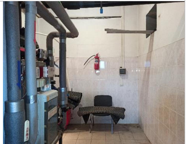
Фото 22. Фрагменты внутренних помещений 1-го этажа
