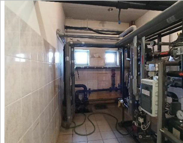
Фото 19. Фрагменты внутренних помещений 1-го этажа
