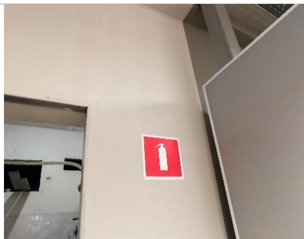
Фото 15. Фрагменты внутренних помещений 1-го этажа
