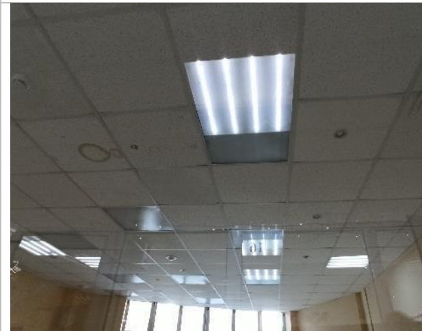
Фото 57. Фрагменты внутренних помещений 2-го этажа
