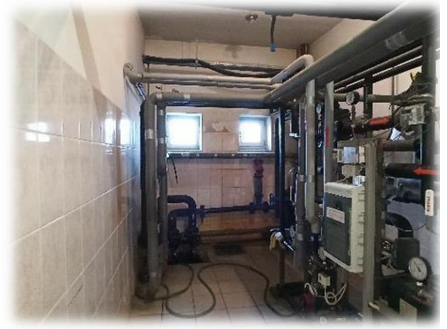
Фотография 3.8. Состояние внутренних помещений
