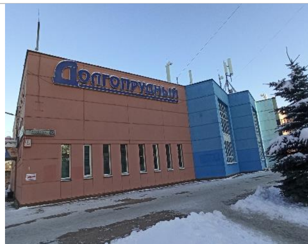
Фото 81. Фасад здания и прилегающая территория
