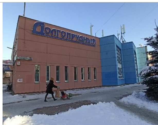
Фото 83. Фасад здания и прилегающая территория
