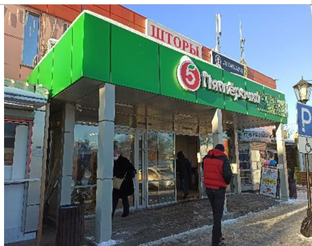
Фото 99. Фасад здания и прилегающая территория
