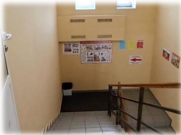
Фотография 3.11. Состояние внутренних помещений
