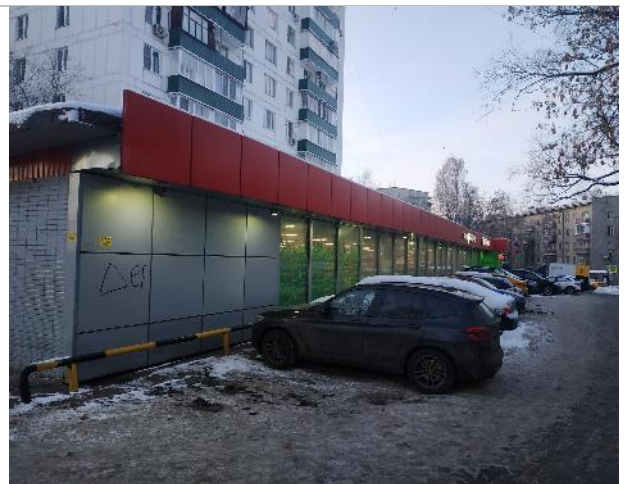
Фото 6. Фасад здания и прилегающая территория
