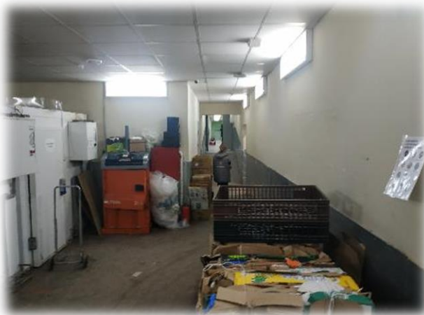
Фотография 3.5. Состояние внутренних помещений
