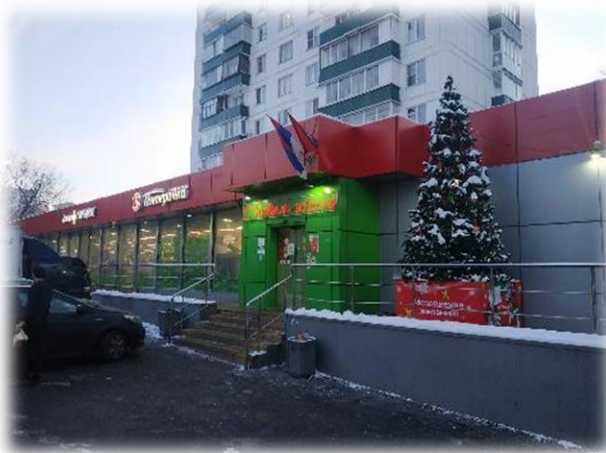
Фотография 3.3. Прилегающая территория, фасад здания
