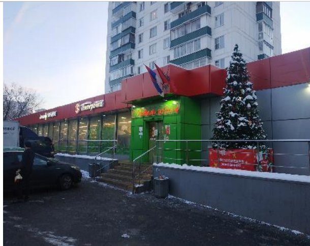
Фото 3. Фасад здания и прилегающая территория
