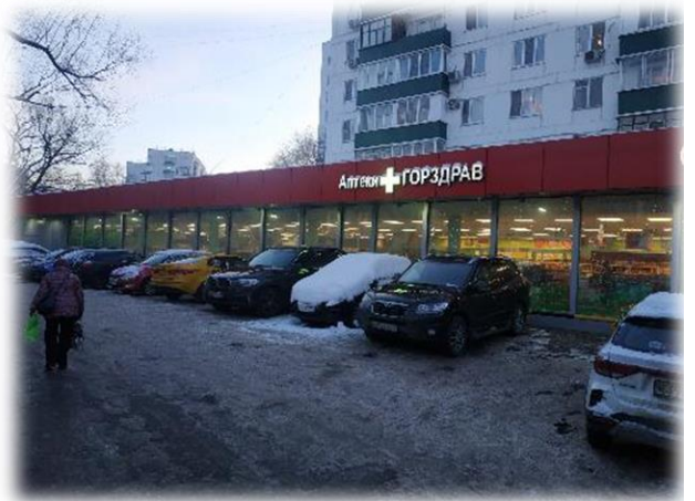
Фотография 3.4. Прилегающая территория, фасад здания
