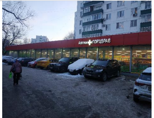
Фото 4. Фасад здания и прилегающая территория
