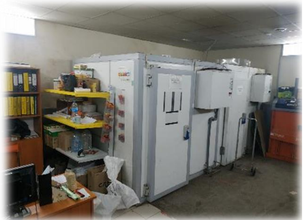
Фотография 3.6. Состояние внутренних помещений
