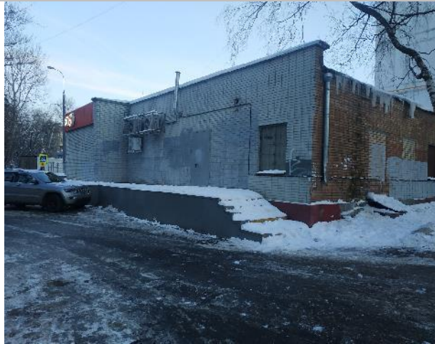
Фото 1. Фасад здания и прилегающая территория
