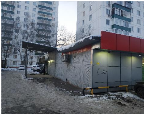
Фото 5. Фасад здания и прилегающая территория
