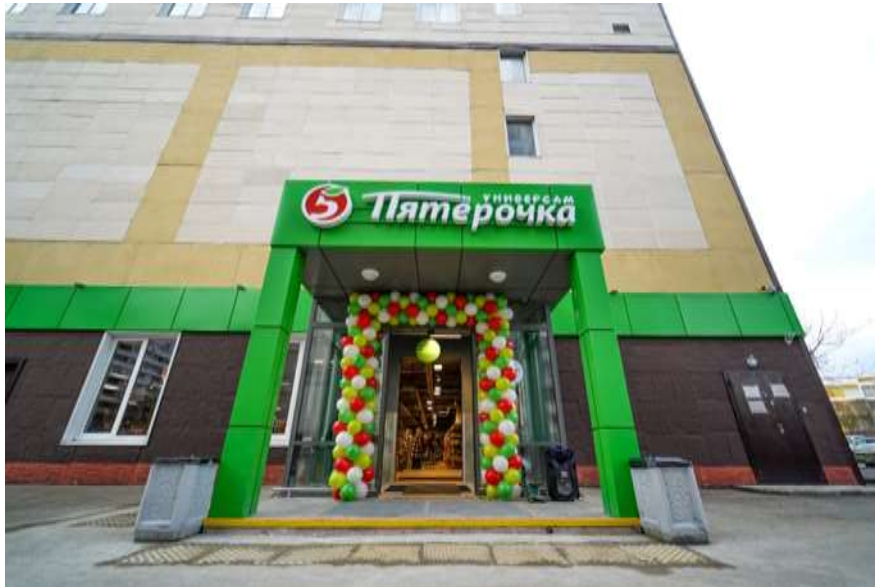
Фото 2. Внешний вид здания, вход в оцениваемые помещения
