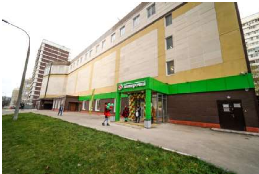
Фото 1. Внешний вид здания, вход в оцениваемые помещения
