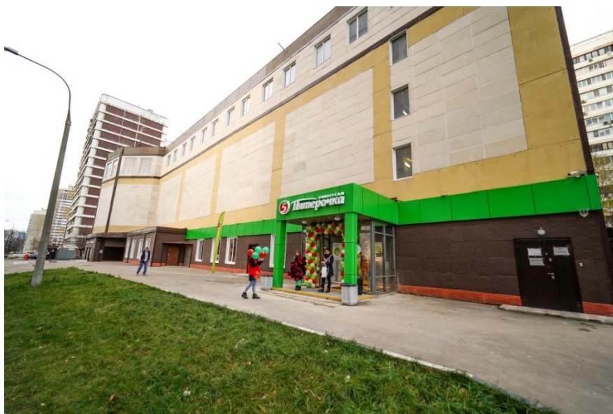
Фото 1. Внешний вид здания, вход в оцениваемые помещения
