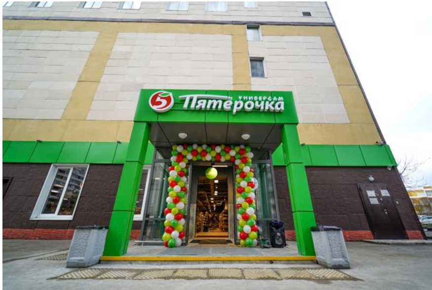
Фото 2. Внешний вид здания, вход в оцениваемые помещения
