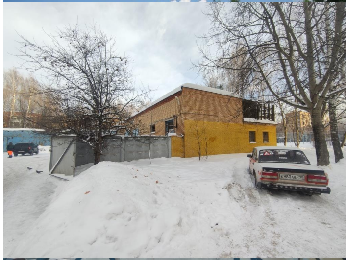
Общий вид здания котельной
