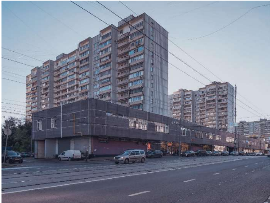
Фото 2. Внешний вид здания
