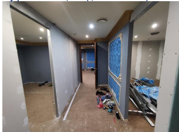
Внутренние помещения (цокольный этаж)
