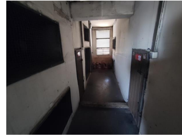
Кровля и техническое помещение (венткамера)
