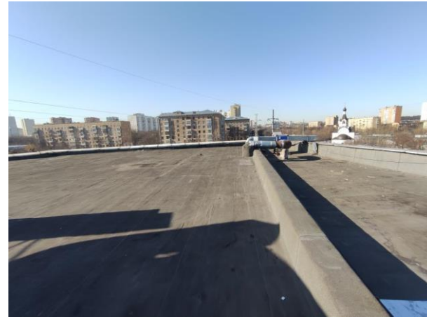
Кровля и техническое помещение (венткамера)
