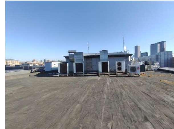
Кровля и техническое помещение (венткамера)
