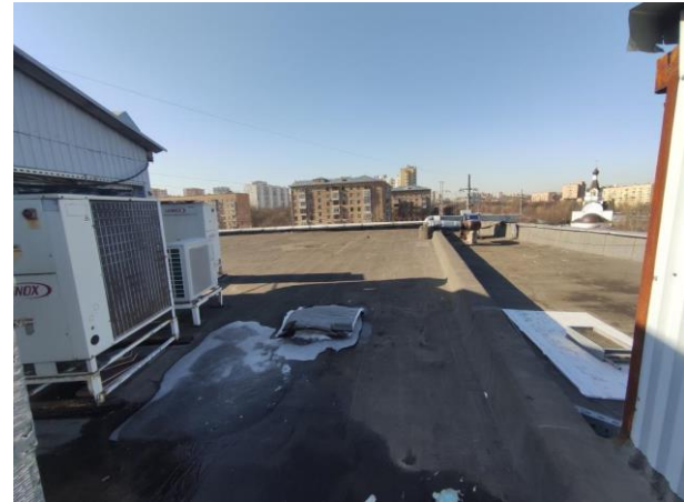
Кровля и техническое помещение (венткамера)
