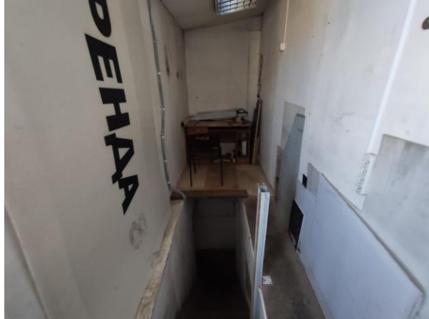
Кровля и техническое помещение (венткамера)
