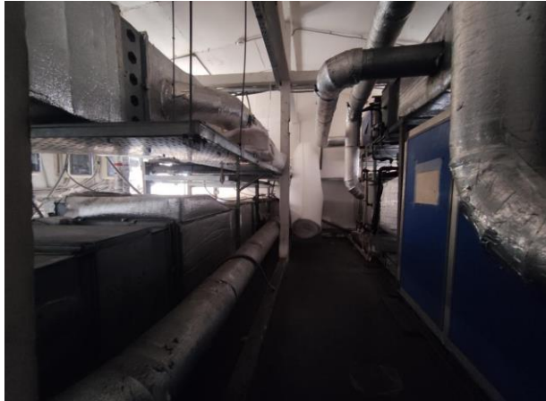
Кровля и техническое помещение (венткамера)
