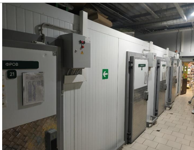
Фотография 3.9. Состояние внутренних помещений
