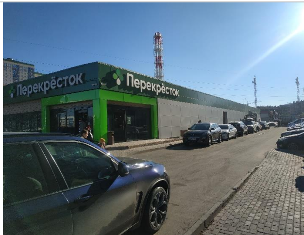
Фотография 3.3. Прилегающая территория, фасад здания
