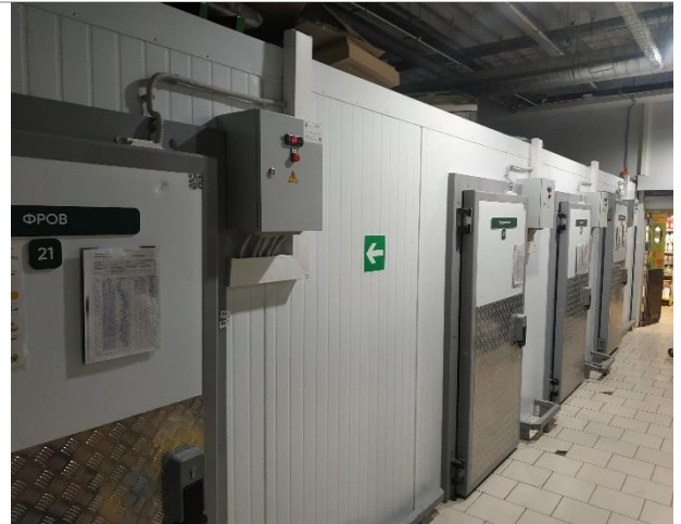
Фото 8. Фрагменты внутренних помещений
